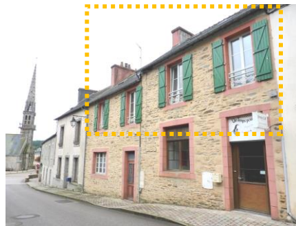
Façade avant (côté rue)
